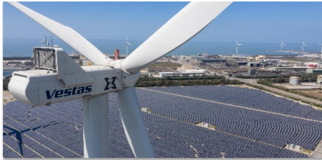
太陽光電 台通台中
