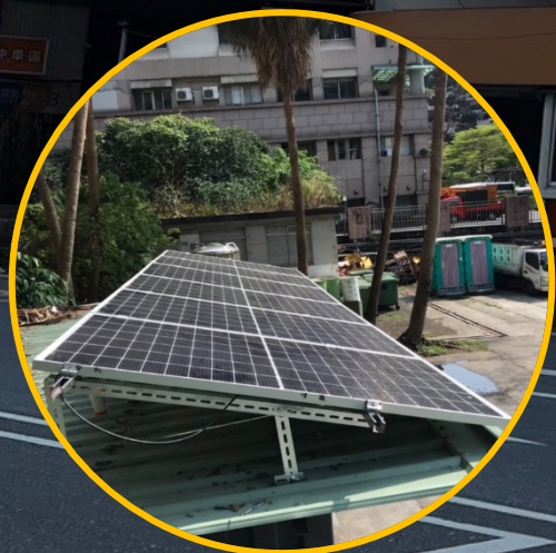
(信義區隊苗圃停車場 架設太陽光電+儲能設施)
